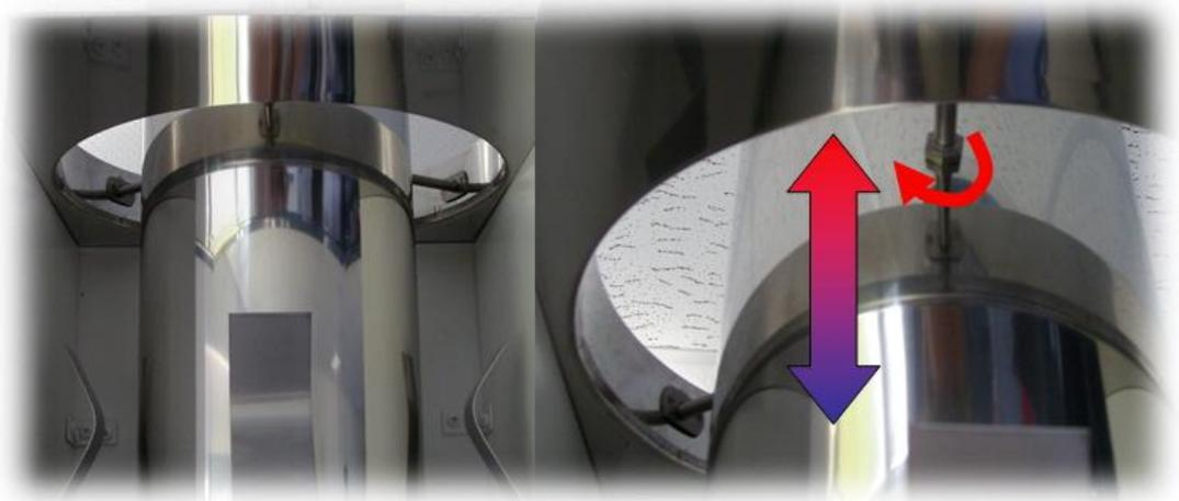
Jetzt nur noch den Regenabweiser mit 30 bis 40 mm Abstand zur Schachtabdeckung montieren, dass genügend Luft zur Belüftung des Schachtes eintreten kann. Dieser muss mit einer geeigneten Dichtmasse zum Rohr hin abgedichtet werden, damit kein Wasser eindringen kann. Generell ist auf eine Blitzschutzanbindung der ES-Anlage zu achten.
