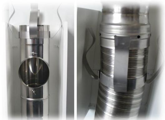
Die Abstandsschellen können Sie entweder direkt auf die Formteile oder aber auch auf dem Flexrohr befestigen (alle 1,5m). Nach der Montage des Adapters diesen einsteckseitig in die Muffe des Formteiles einschieben. Danach Maß festlegen bis zum nächsten Formteil, z. B. Feuerungsanschluss oder weitere Reinigungsöffnung, etc. Flexrohr auf dieses Maß ablängen mittels eines Winkelschleifers oder einer Eisensäge. Vorgehensweise wiederholt sich bis zur Mündung.
