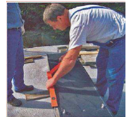
...auf Stülpkopf übertragen und entsprechend ablängen...
