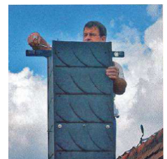
...durch der durchdachten Montagetechnik lässt sich der Stülpkopf noch exakt lotrecht ausrichten...
