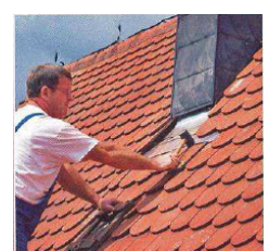
...dann auch unterhalb, Bleiblech mit Gummihammer flach klopfen damit Ziegel sicher liegen.
