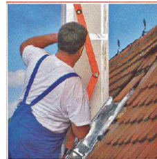
...vor Montage des Stülp-kopfes wird der Winkel der Dachneigung ermittelt...
