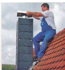
...Edelstahl-Abdeckplatte als Verschluss montieren...
