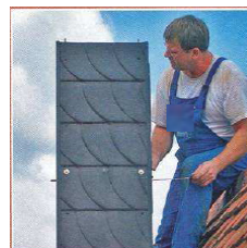
...der Stülpkopf lässt sich nun fixieren und Klapper-geräusche sind ausge-schlossen...
