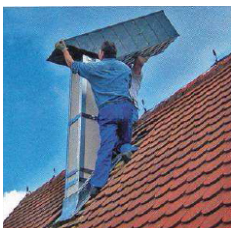
...so vorbereitet wird die Außenhülle über den Kamin gestülpt...
