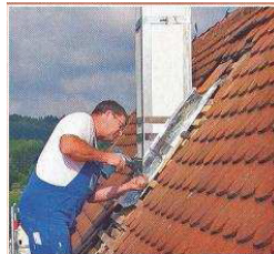
...sichern, indem Schrauben und Randhaltetaschen auf die Dachlattung montiert...
