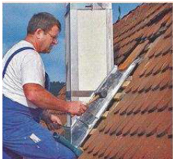
Die beiden Hälften der Kamin-einfassung ineinander schieben und zurecht Klopfen...
